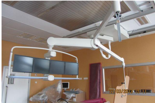
Rys. 1. Sala operacyjna (zdjęcie wykonane przez Autorkę artykułu podczas przeprowadzania pomiarów).
